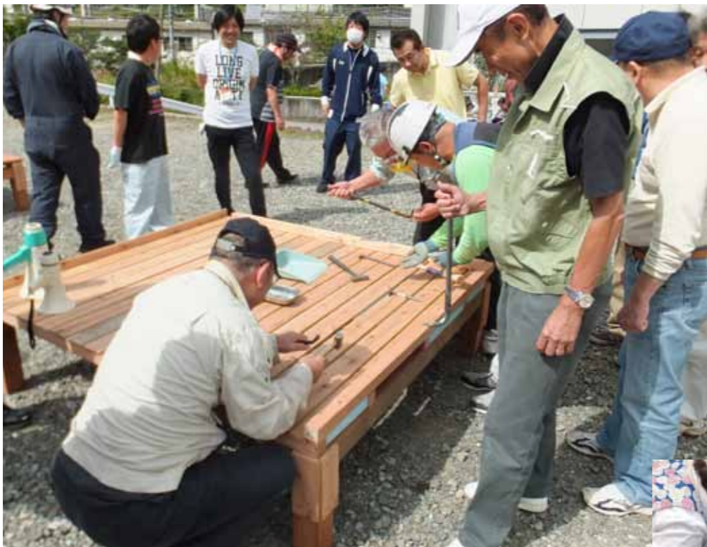
▲床板剥がし訓練
